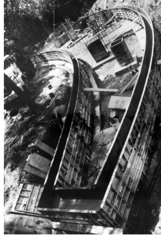
Die stillgelegte Baustelle des Slow House
