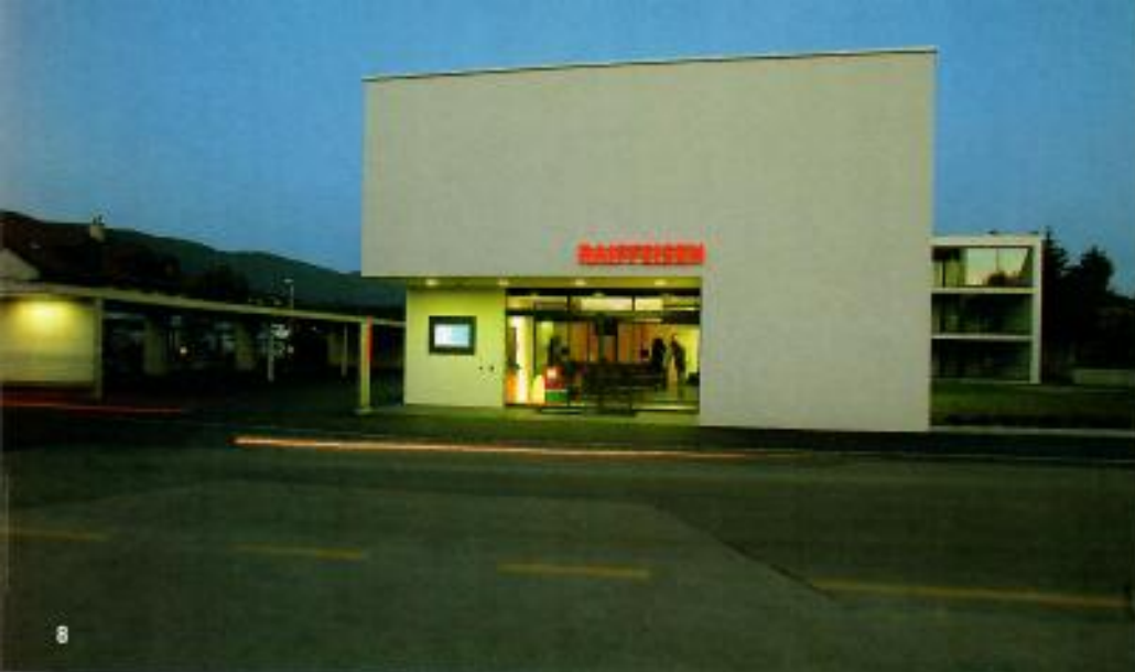
8 L'entrée de la banque mène également à la place située à l'arrière du bâtiment
