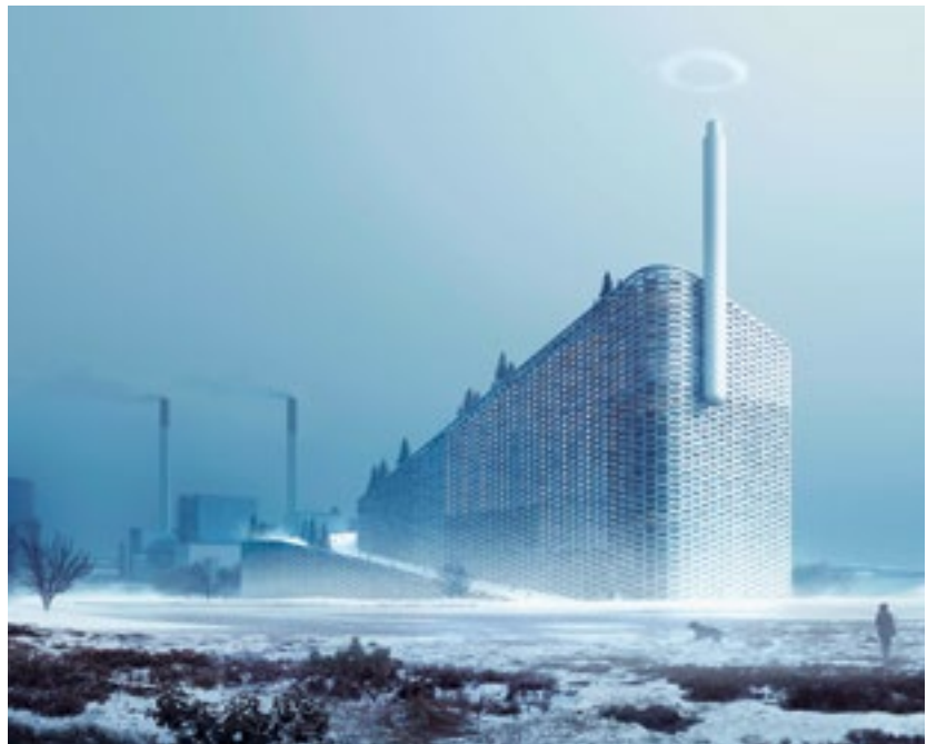
Die neue Müllverbrennungsanlage für Kopenhagen von BIG auf Amager, (Fassadenkonzept: Dr. Lüchinger + Meyer, Zürich). Auf dem Dach soll eine Skipiste entstehen, ein Kunstrasenteppich bildet den Untergrund für die Schneeeauflage – künstlich beschneit wird natürlich nicht.
