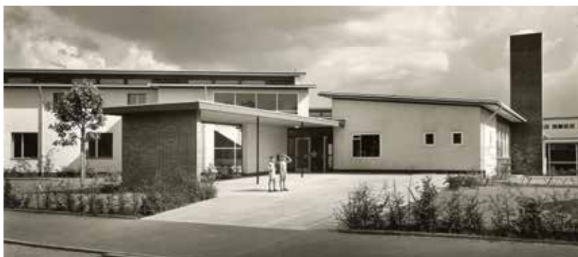
Der Schulbau von Rasser & Vadi Architekten aus den 1950er-Jahren im Original: In der Nachkriegszeit war das Material knapp – und führte dafür zu präzisen Konstruktionen. Den Bau zeichnen reiche Details, ein ausgereiftes Raumkonzept sowie der bewusste Einsatz von Farbe und Oberflächen aus. Archivbild.
