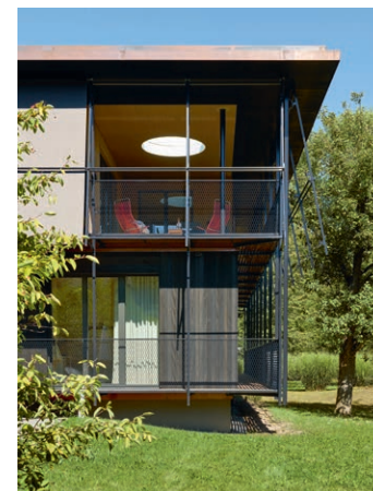
Obergeschoss mit Balkonschicht Umbau Villa, Bern Top floor with balcony layer Villa conversion, Bern
