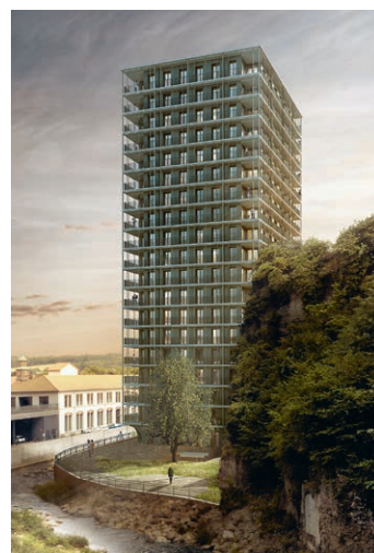
Vorgehängte Gitterstruktur Wohnhochhaus Taubenloch, Biel Mounted grid structure Taubenloch high-rise housing, Biel
