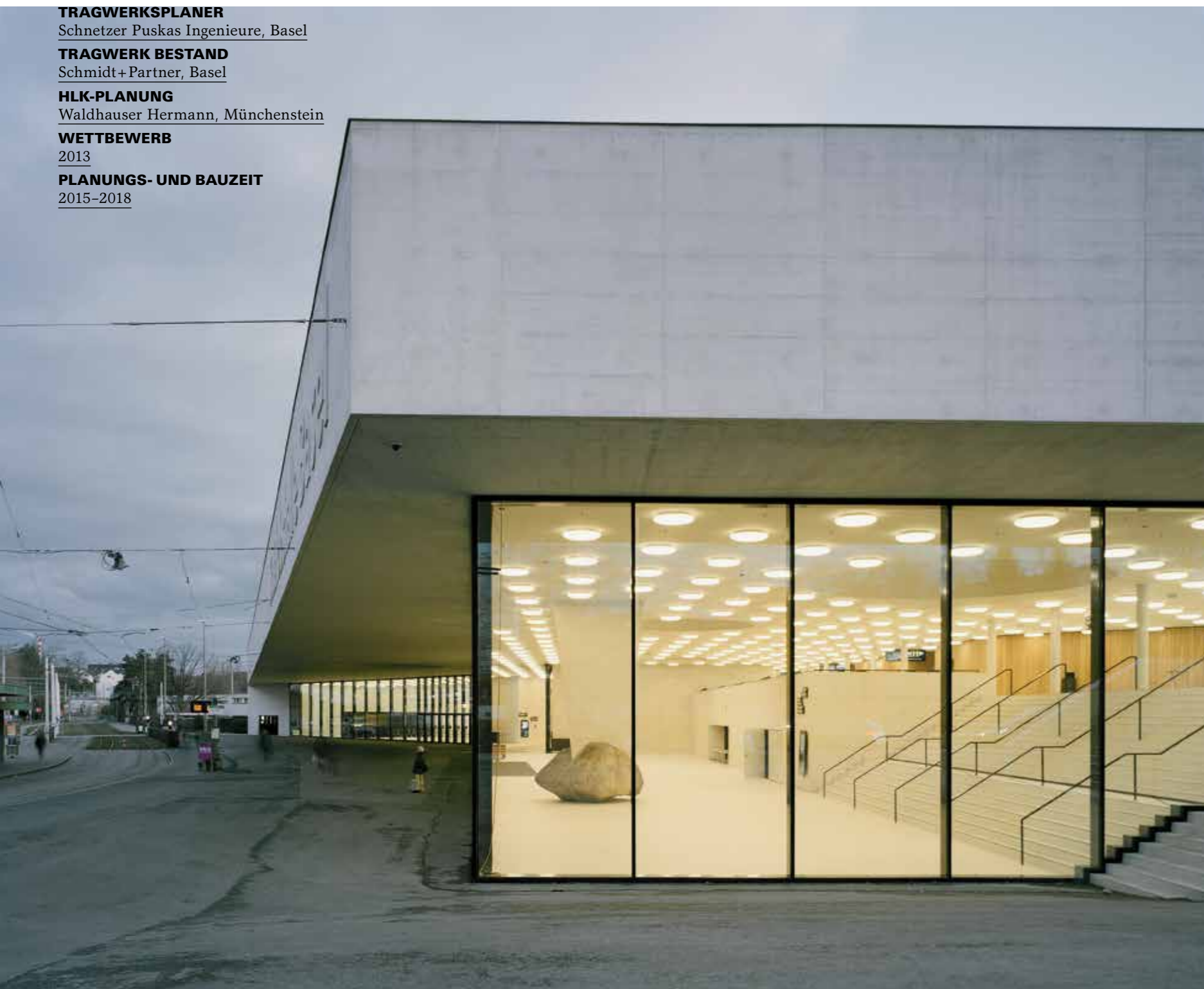
Der Vorplatz, das Foyer und die markante Dachauskragung sind die drei wesentlichen Elemente der erweiterten St. Jakobshalle.
