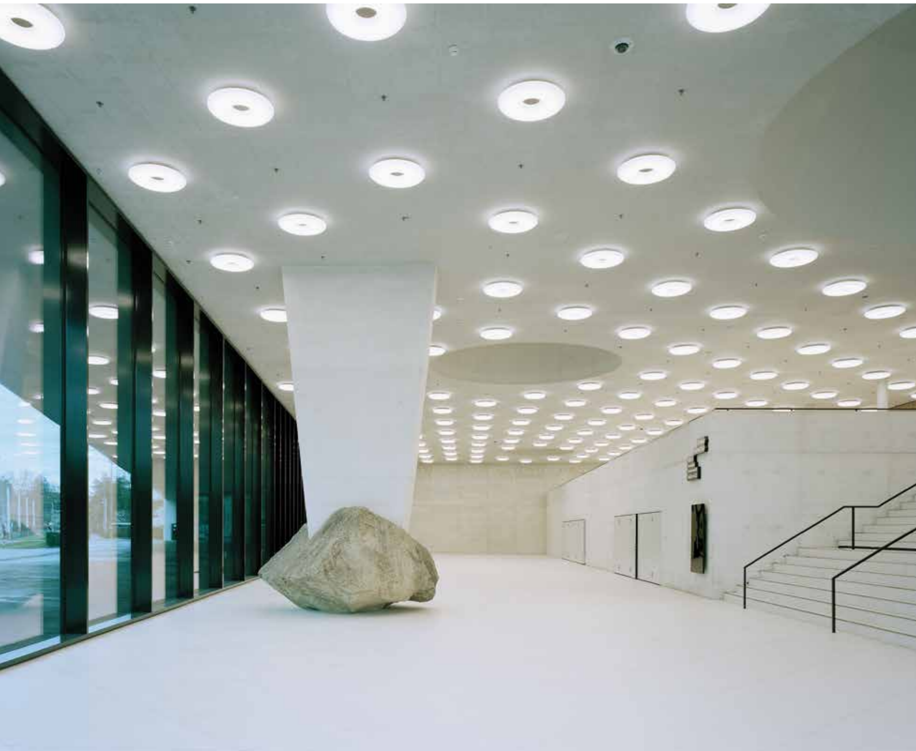
Der Findling des Künstlers Eric Hattan verdeutlicht die punktuelle Lastabtragung des Daches über die skulpturale Pendelstütze.
