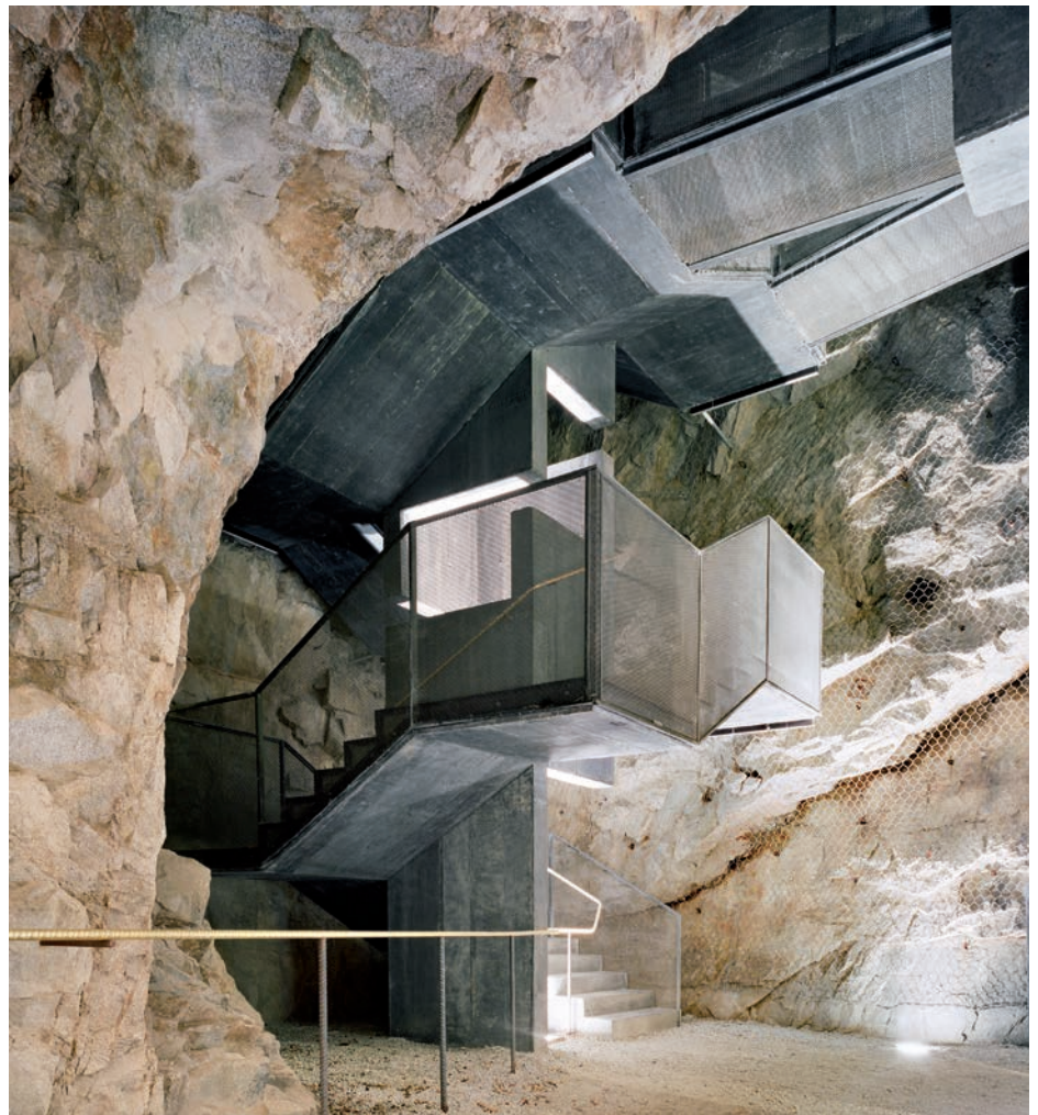
Innerhalb des Felsens führt eine skulpturale Stahlbetontreppe von der unteren zur mittleren Festungsebene. (Foto: Alessandra Chemolo)
