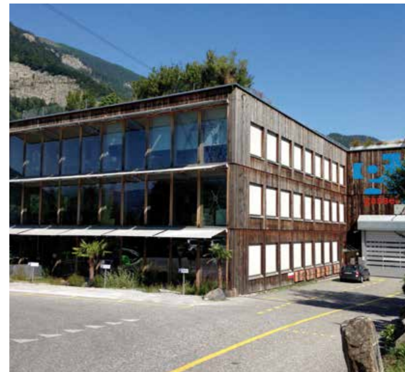
Festverglaste Südfassade mit aussen liegendem Sonnenschutz.
