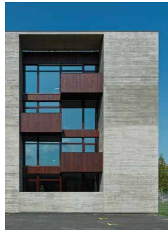
Die Ost- und die Westfassaden sind im Verhältnis klein und weitgehend geschlossen.
