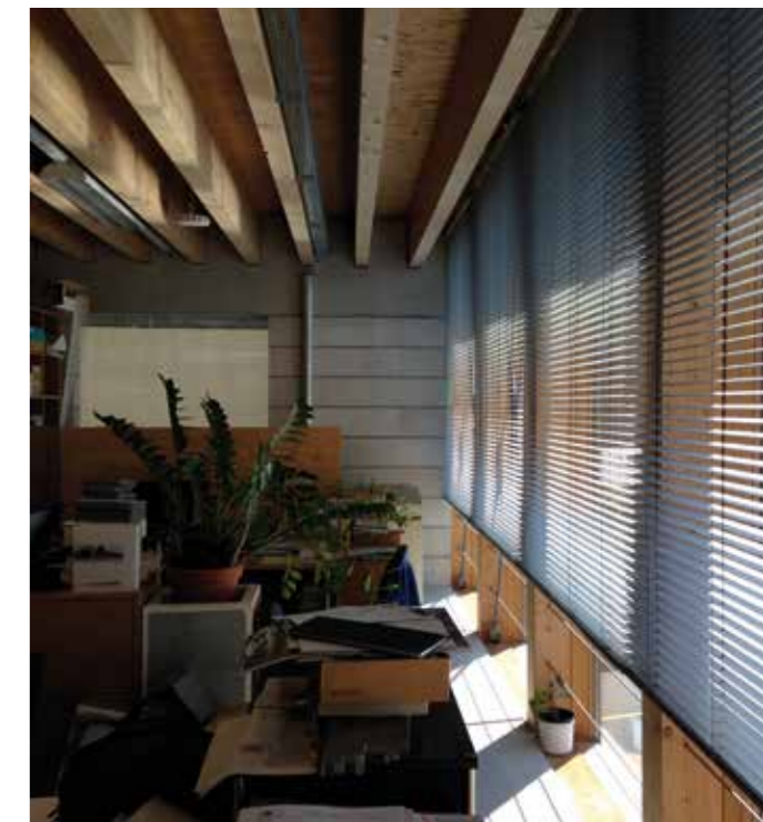
Die sichtbaren Kalksandsteinwände und Brettschichtholzträger an der Decke werden ebenfalls als Speichermasse genutzt.
