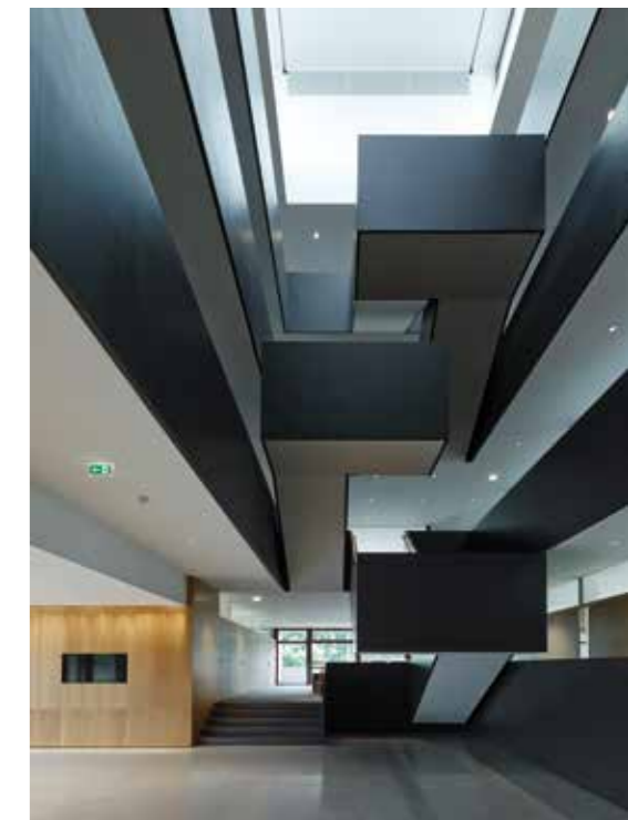
An den Erschliessungszonen kann warme Luft bis in die Laternen über dem Gebäude aufsteigen.
