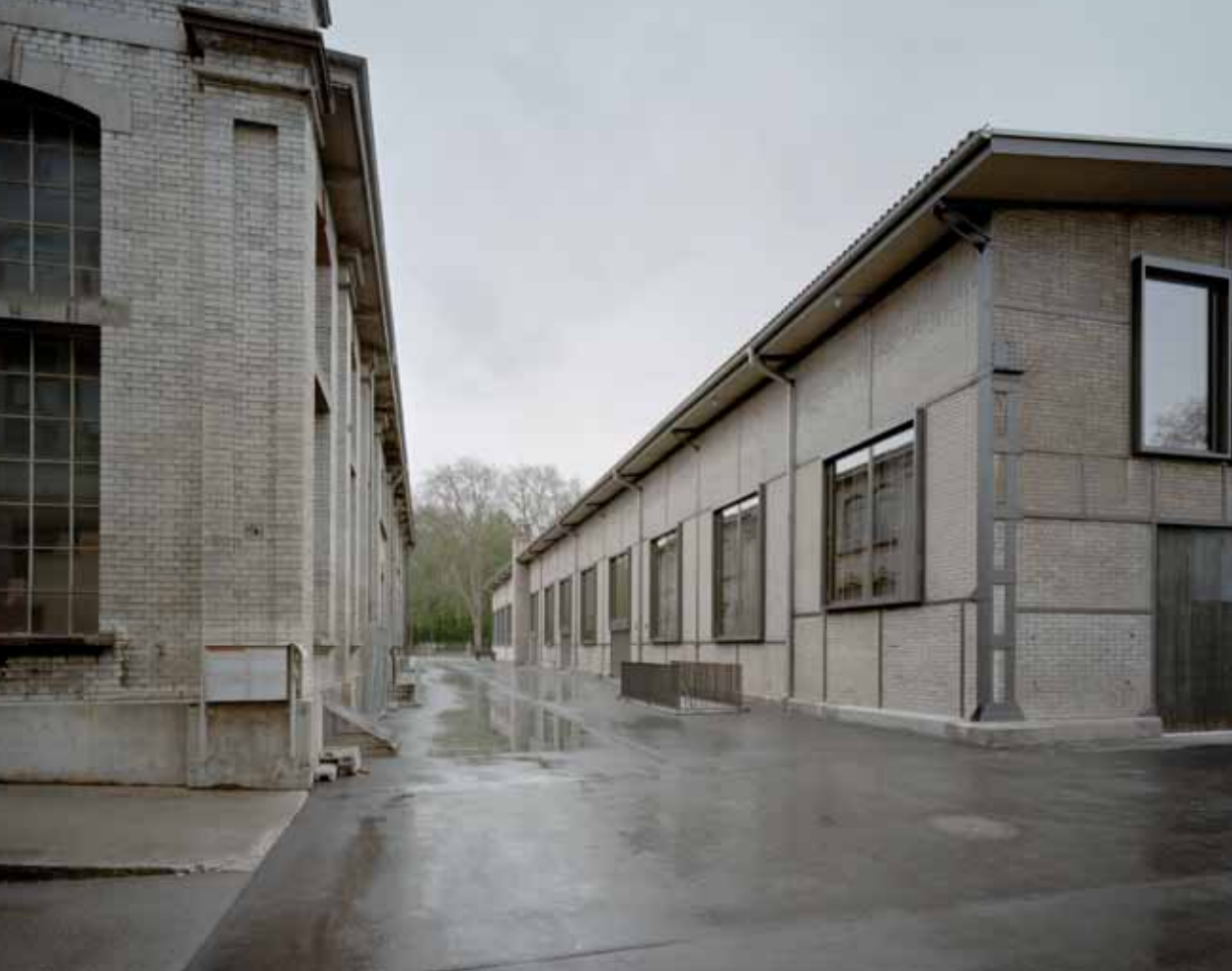
Blick zwischen die umgenutzte Weichenbauhalle und ein Fabrikgebäude.
