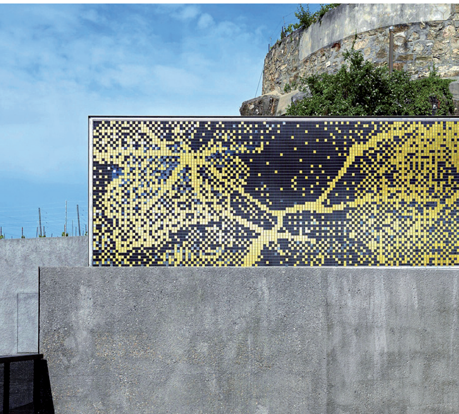
Rund 6000 kleine Spiegel aus Messing und rostfreiem Stahl verhängen die Fassade und komponieren ein Rebblattmotiv.
