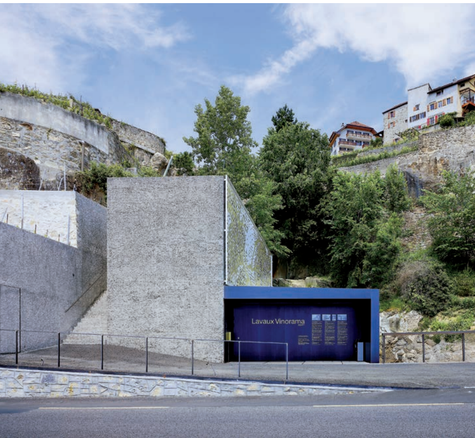
Links vom massiven Baukörper führt eine steile Treppe als externer Zugang zum Konferenzraum. Rechts markiert ein eingezogener, verkleideter Windfang den Hauptzugang.
