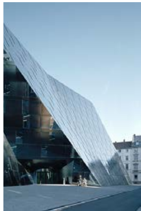
Die 14 unterschiedlichen Fassadensegmente neigen sich bis 28 Grad nach Innen und 16 Grad nach Aussen.
