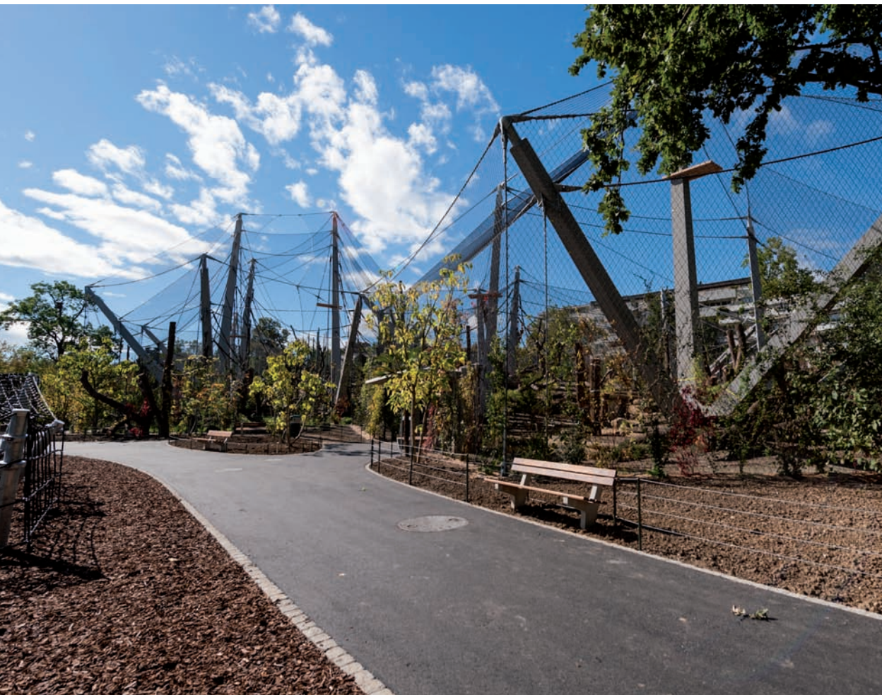
Nicht mehr lange, dann wird die äussere Haut der Netzräume von Kletterpflanzen überwuchert sein.
