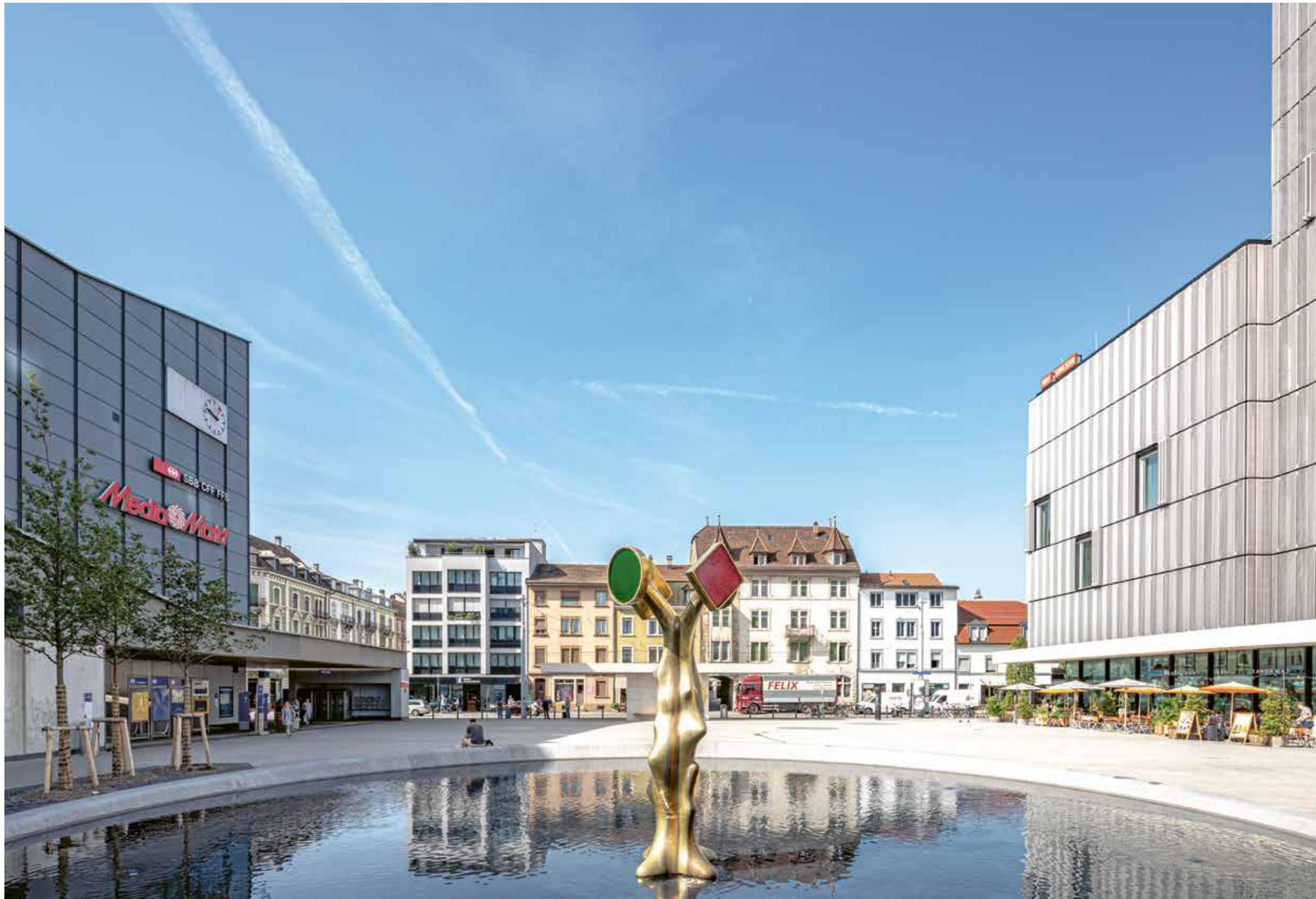
Der Brunnen mit Skulptur bildete bei der Gestaltung des Bahnhofplatzes ein zentrales Element. Rund 19 m Durchmesser hat das flache, kreisrunde Becken, aus dessen Wasseroberfläche die Bronzesäule mit vier leuchtenden Augen hervorsticht.
