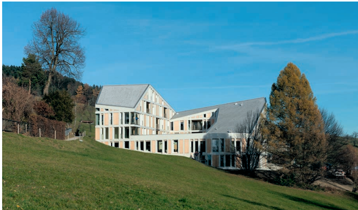
^ Der Neubau ist eine Symbiose von ländlichen Traditionen und urbanen Gebäude- und Wohnformen.
