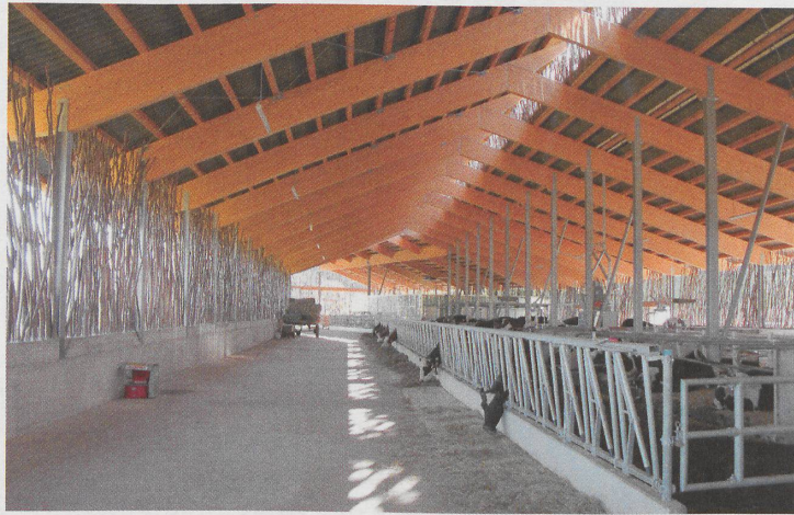
1 Die in der Brüstung einbetonierten, lokalen Haselnuss-Stauden erzeugen ein Licht- und Schattenspiel im Innern des Stalls.
